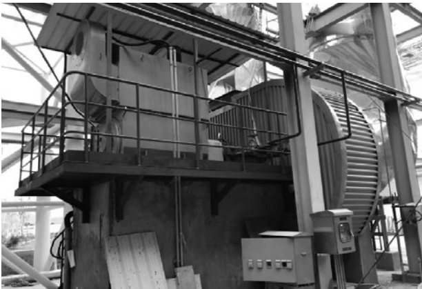
(d) 引风机基础增加平台、爬梯
