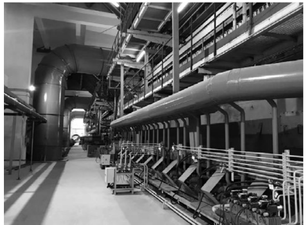
(b) 焚烧间7.5m层炉前纵向检修通道
