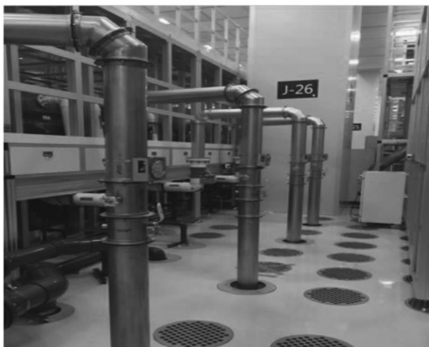
图3 工艺设备公用二次配现场安装图
